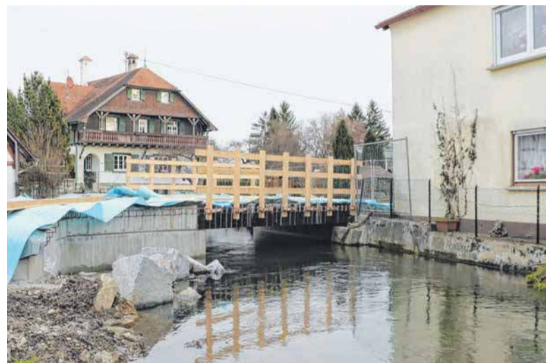
Die Sanierung der Gießenbrücke in Sinningen macht derzeit Winterpause.
